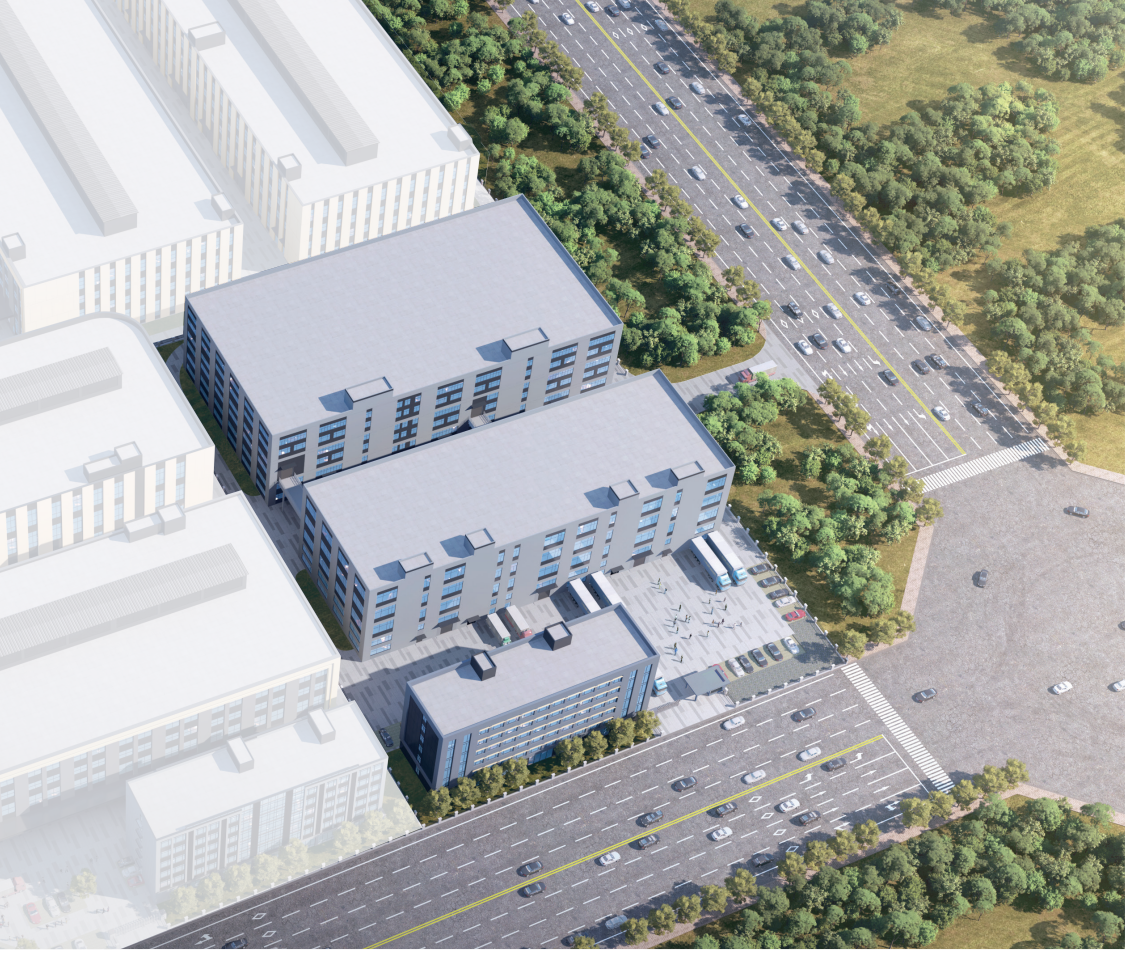
沿街全（综合楼、车间）
