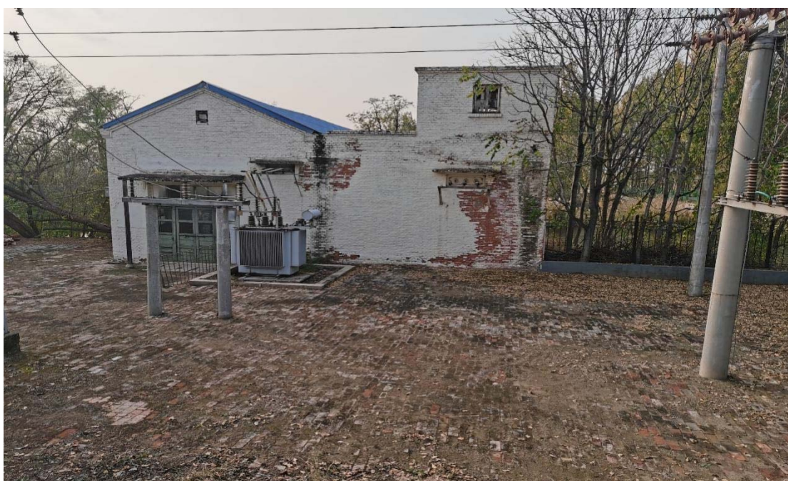
图2.3-8 蒲口扬水站现状
